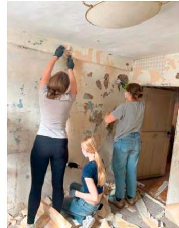
Wir haben alte Tapeten entfernt, die darunter liegenden Balken freigelegt und die Wände fachgerecht verputzt. Ein Loch in der Decke zum Dach wurde verschlossen. Nach einer gründlichen Reinigung haben wir die Wände und Decken im Raum gestrichen, was neue Frische und Helligkeit bringt. Zum Teil wurden schon neue Lampen installiert. Mittlerweile haben auch schon die ersten Möbelstücke Einzug gehalten, sodass wir einen der Räume bereits nutzen können.
